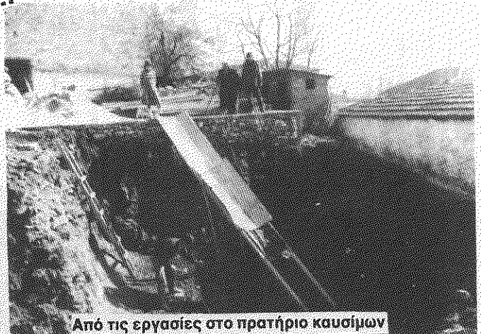
Από τις εργασίες στο πρατήριο καυσίμων
